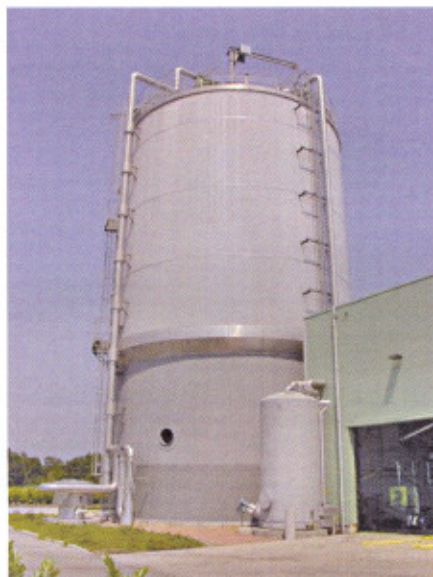
Die bislang größte Dranco-Anlage im belgischen Brecht verarbeitet Bio- und Gartenabfälle sowie nicht wiederverwertbares Papier und Wegwerfwindeln.
